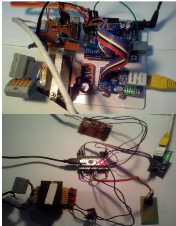
Fig. 9. Stadiul initial de execuție
